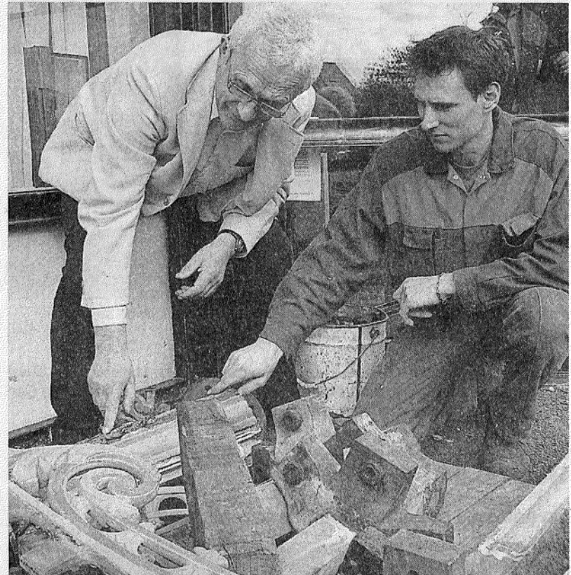
Rémy Crézé (à gauche) et Martin Loste, responsable du chantier, ont été aussi surpris qu'amusés de découvrir que la stabilité des poteaux était assurée par des morceaux de journaux d'époque.
